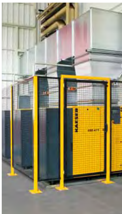
Установленная в одном из производственных цехов компрессорная станция поставляет сжатый воздух на контрактной основе, в том числе и для шлифовальных станков, снабженных собственными ресиверами (справа)
